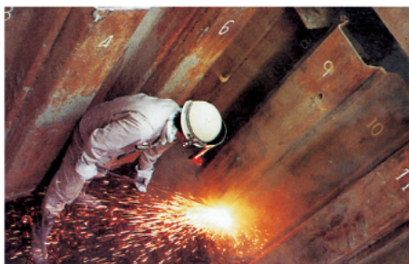
1. シートパイル熔断
