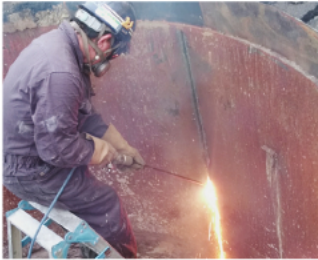
ケーシング熔断作業
