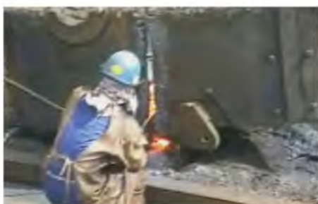
3. 大型プラント熔断解体作業
