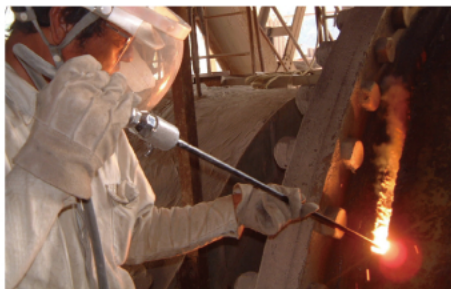
3. 大型製造プラントの解体
