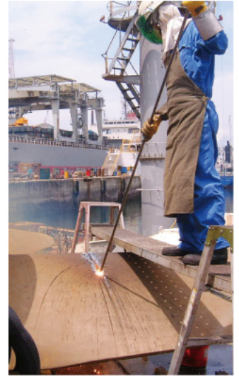
大型スクリー解体作業
