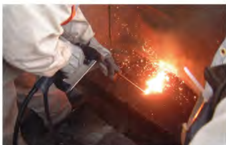
1. 高速道路のリフレッシュ作業
