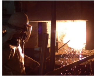
炉前出湯口の開削作業
