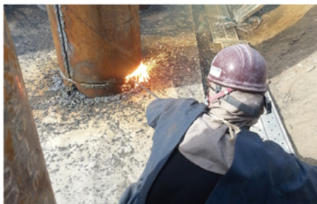
4. 鋼管杭の熔断
