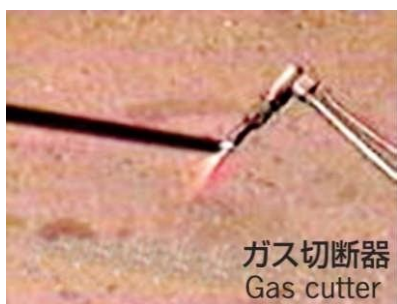
ガス切断機による着火の様子
